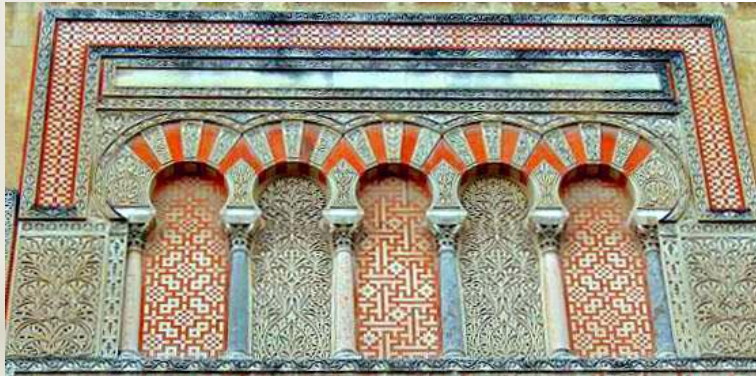
Arcos exteriores del muro este
